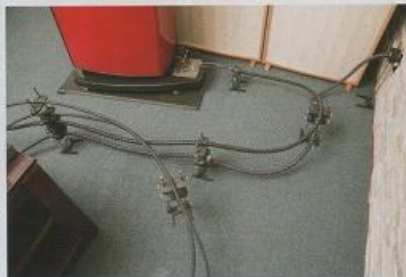
同じブランドの機器は電源端子の位置がほぼ似通った位置のため、タワー型に延長すれば共通でサポートすることも可能
