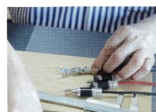
④絶縁をいたケーブルにターミナルを取りつけているところ
