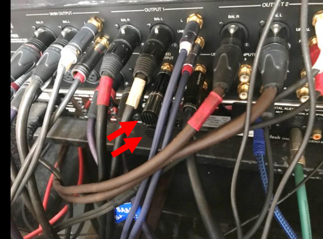
チューブプリアンプ 固定出力側 L/R端子へ
